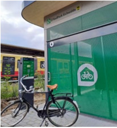
VBB-RadParks sind mit Fahrrad-reparatursäulen ausgestattet.
